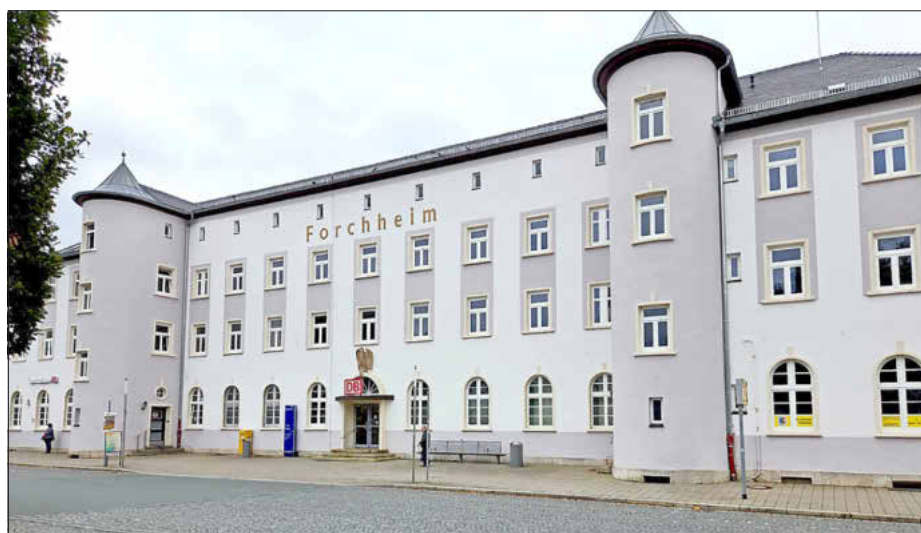
Die Westfront des neu renovierten Forchheimer Bahnhofsgebäudes
