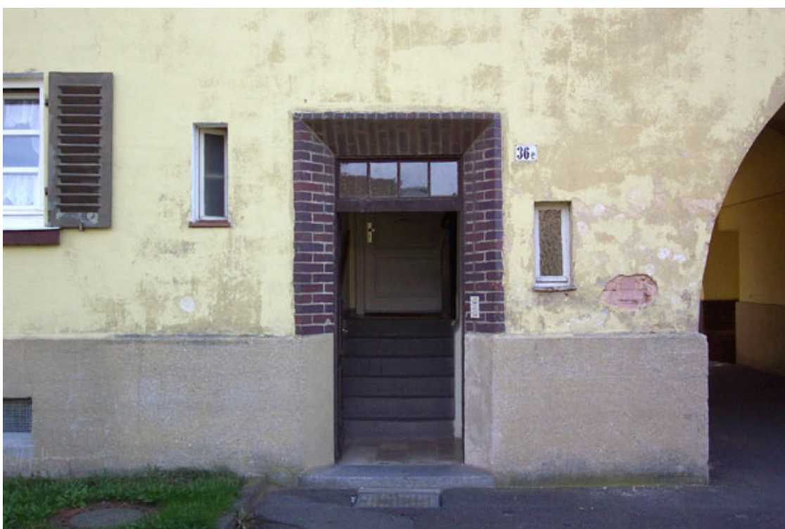
"Ehemaliger Nordbahnhof" Gebäudezustand (Foto Ebe)
