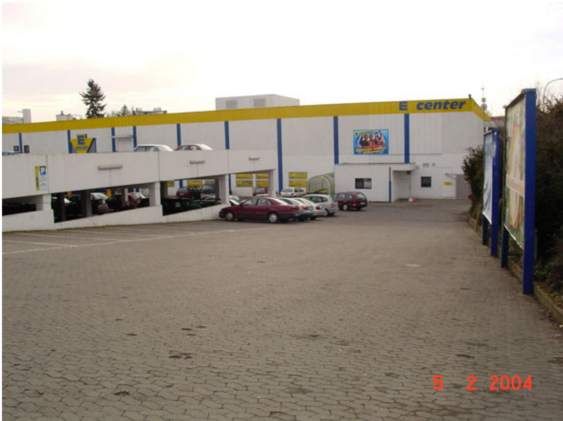
Großparkplatz E - Center (Foto Stadt Forchheim)
