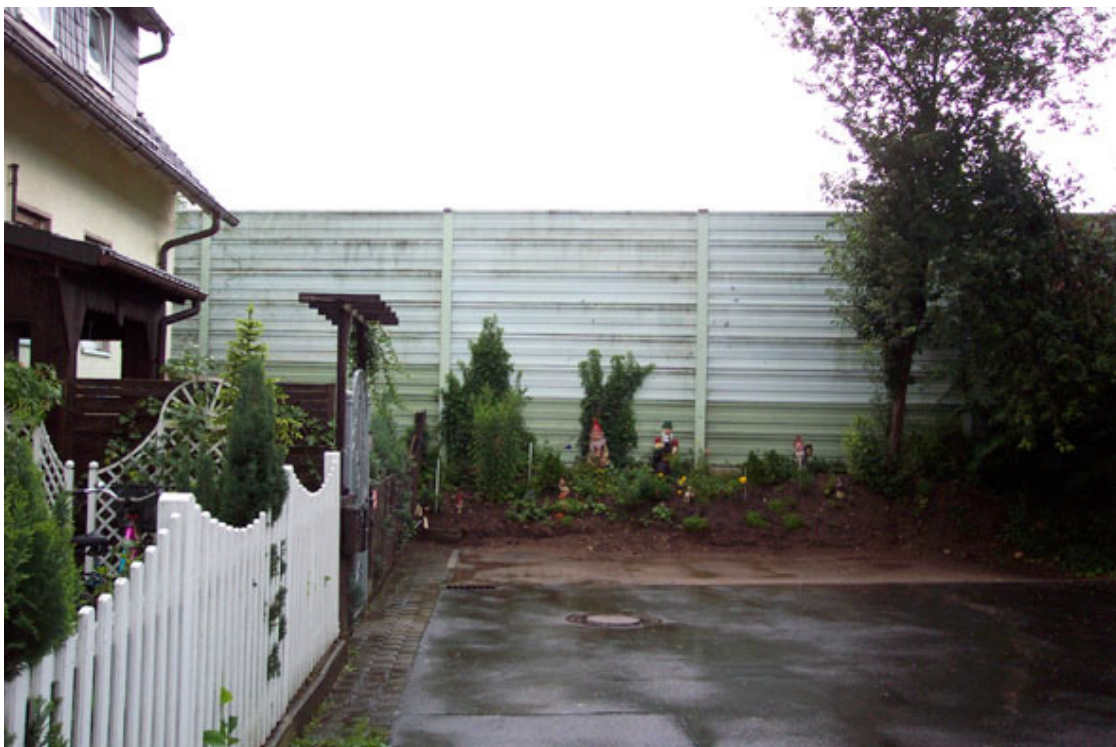
Lärmschutzwand entlang der Autobahn (Foto Ebe)
