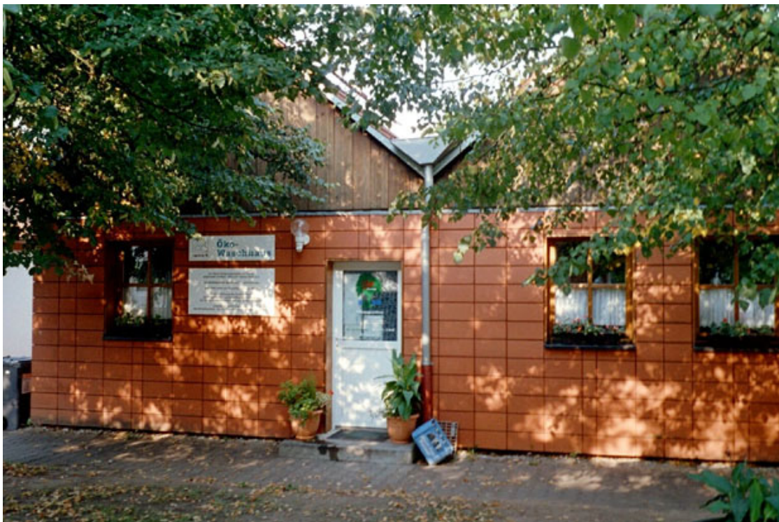
Vorplatz Waschhaus (Foto intep)
